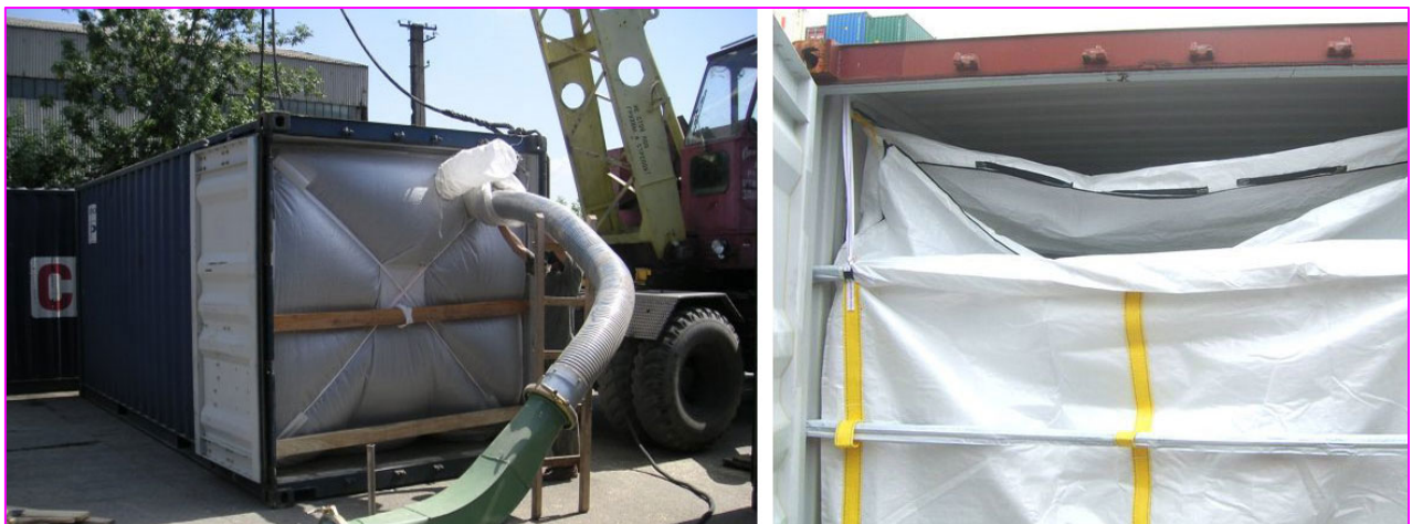
Рис 4. Загрузка контейнера с вкладышем
